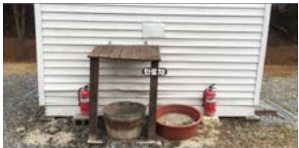
숯 및 잔불처리 시설 설치의 좋은 예 (재수거함 옆 소화기 및 방화사 비치)
