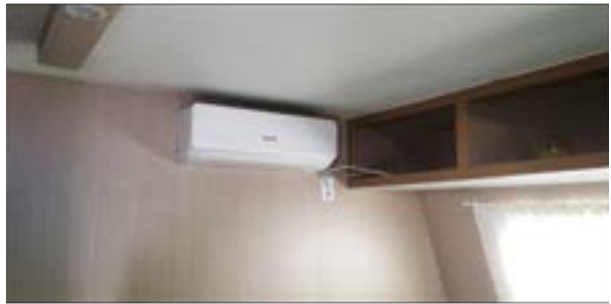
야영용 트레일러 내 연기감지기 설치의 좋은 예
