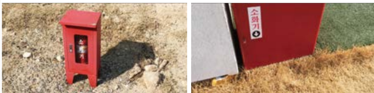
소화기 설치의 좋은 예(소화기 함 및 표시)
