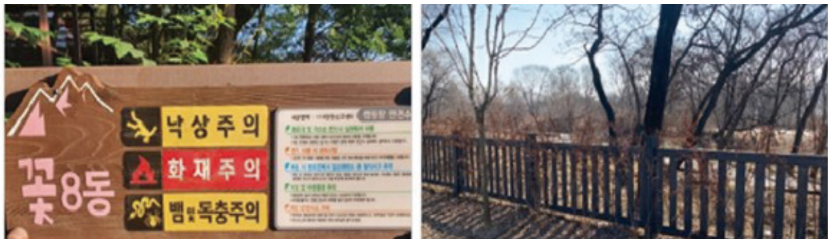
낙상 우려 난간 설치 및 위험 안내표지 설치 사례
