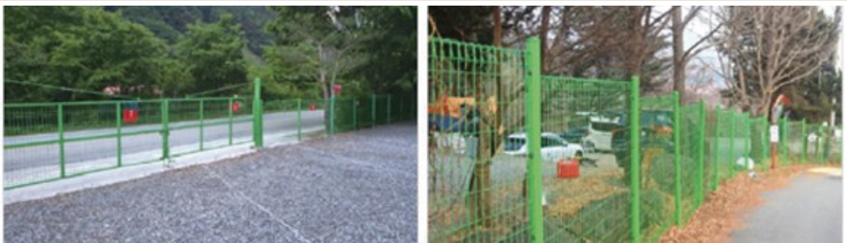
안전울타리 설치 사례
