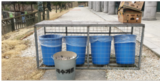
숯 및 잔불처리 시설 설치 장소의 잘못된 예 (쓰레기통 옆 위치 및 소화기 미비)
