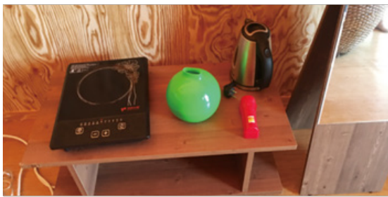
바닥의 기초와 기둥을 갖추고 지면에 고정된 야영시설(글램핑텐트) 내 비상손전등 설치의 좋은 예
