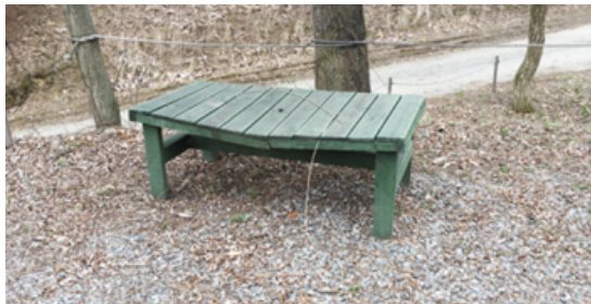
시설물 관리의 잘못된 예(파손된 시설물 방치)
