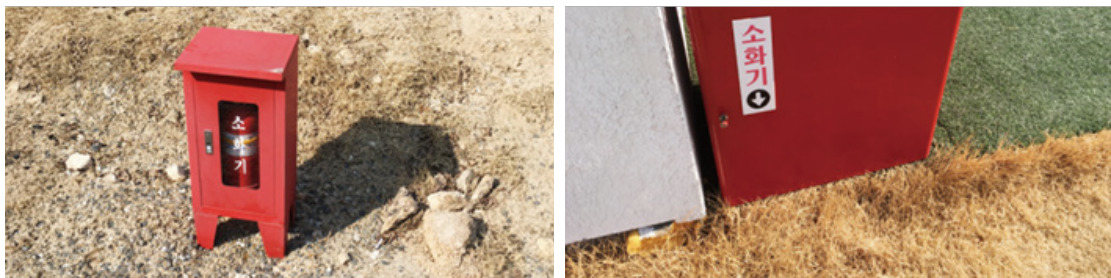
소화기 설치의 좋은 예(소화기 함 및 표시)
